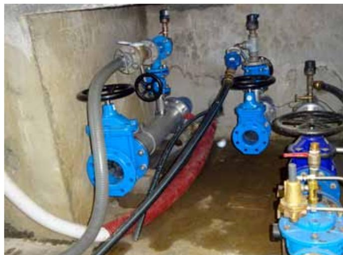
Wasserbehälter nach den durchgeführten Erneuerungsarbeiten mit Armaturen auf dem neusten technischen Stand
