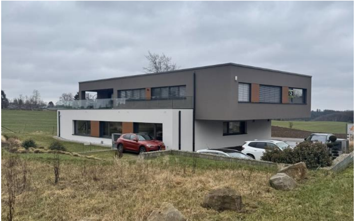
Abbildung 5: Westlich angrenzendes Gebäude
