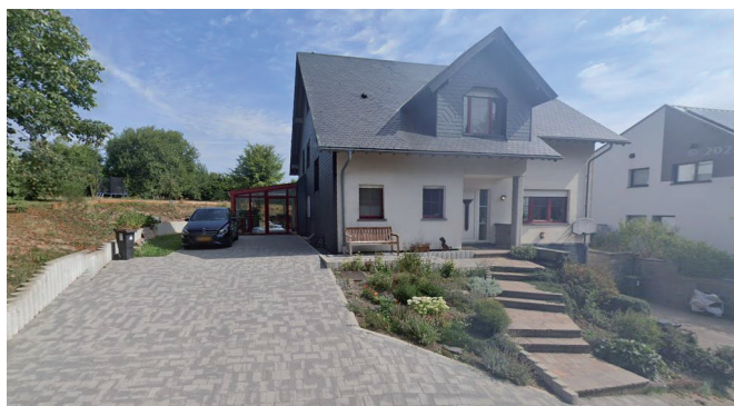
Abb.66: Ansicht von Straße Op der Heed - T18
